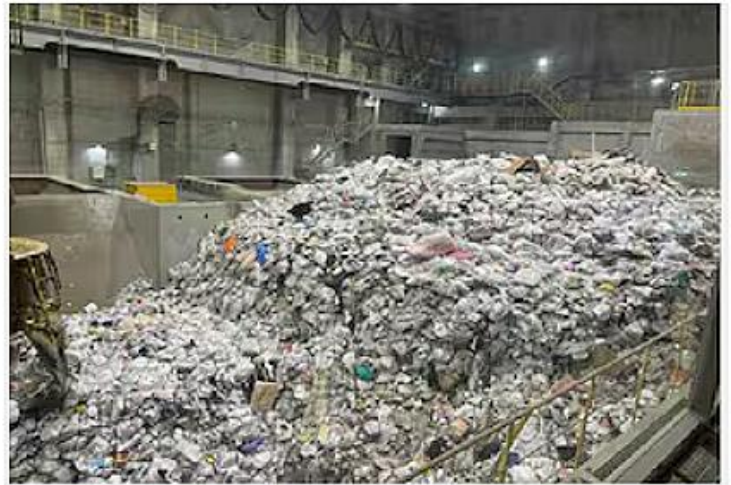
ごみでピットがほぼ満杯状態の焼却工場＝大阪市住之江区（大阪広域環境施設組合提供）
