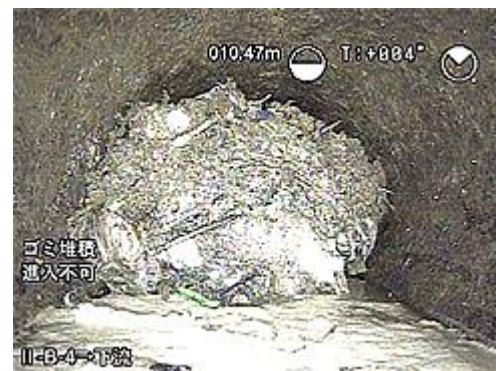
輸送管内部の状態
