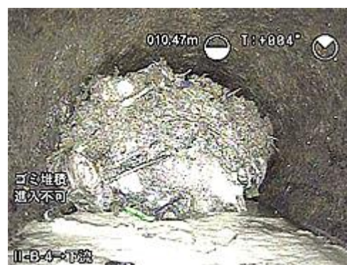
輸送管内部の状態
